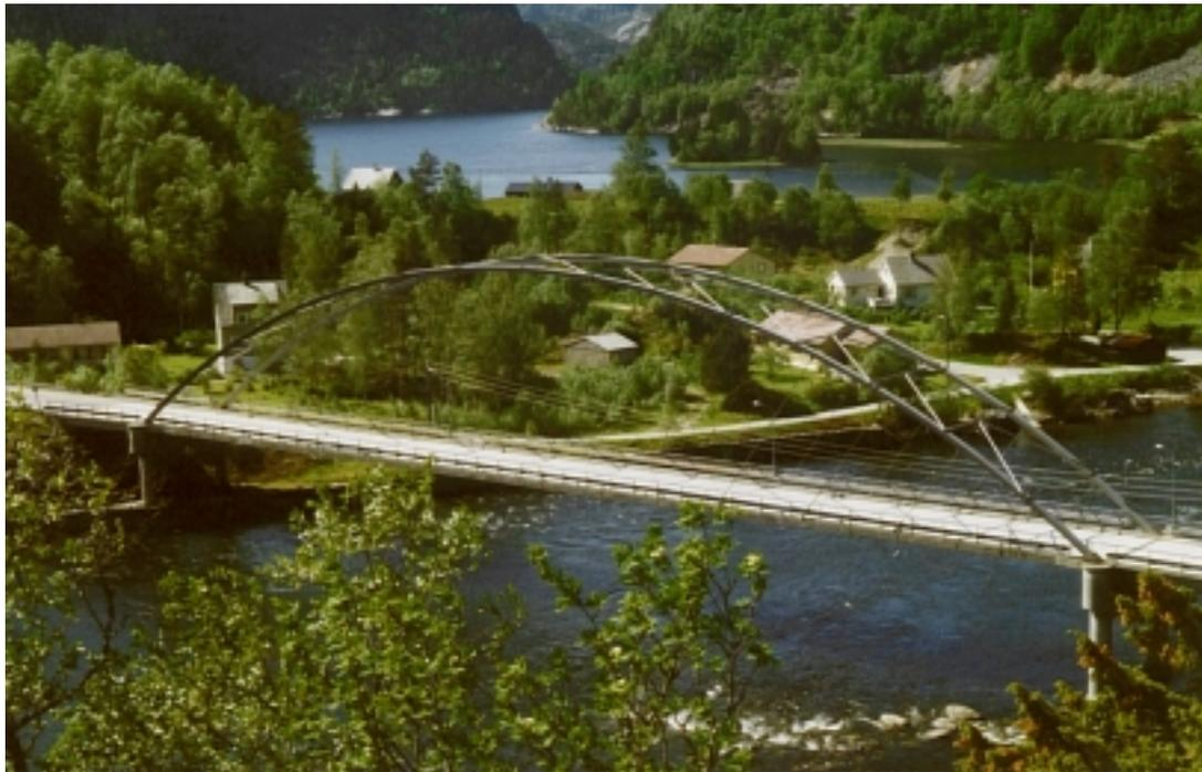
**Abbildung 4:** Bolstadstraumenbrücke in Norwegen, Spannweite 84m, Entwurf: Per Tveit
