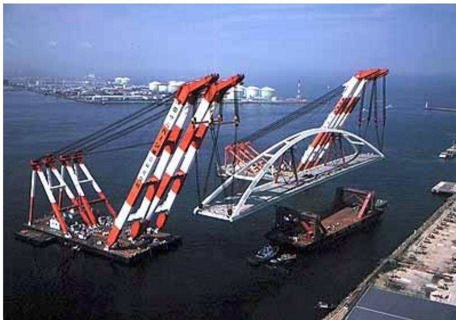
**Abbildung 22:** Transport der Shinhamadera-Bridge, Japan, 1991, Spannweite: 254 m
