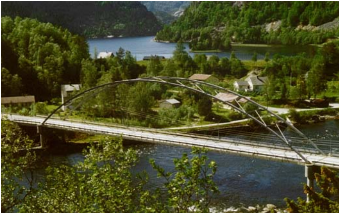
Fig. 27. Bolstadstraumen Bridge. Span 80 m.
