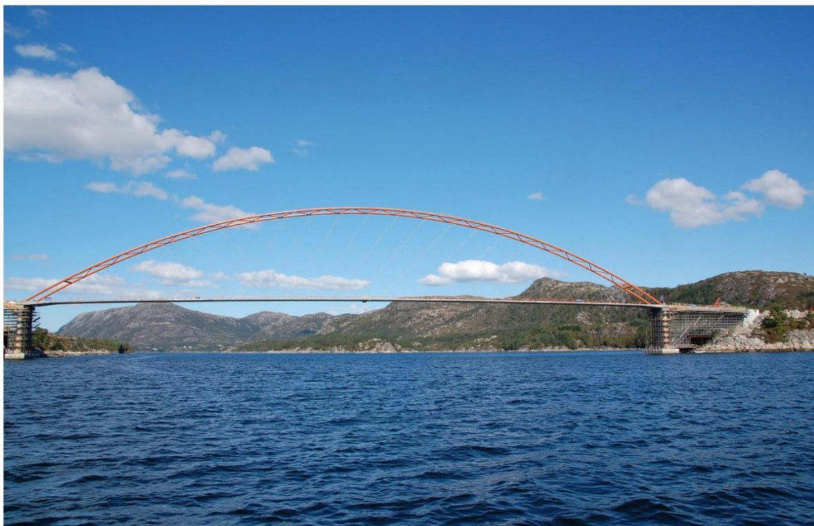
Brandanger Bru i Gulen för rekkverket vart montert. Spennvidde 220 m.
