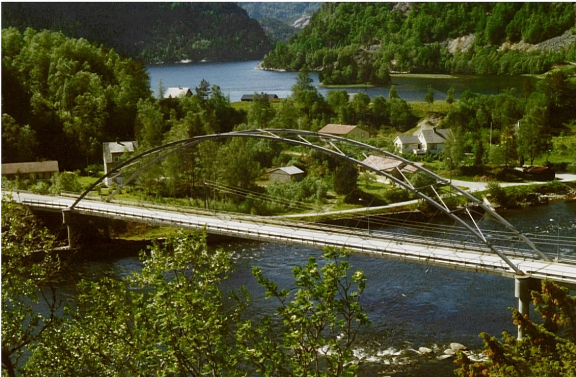
**Abbildung 5:** Bolstradstraumenbrücke, Norwegen, Spannweite 84 m, Entwurf PER TVEIT
