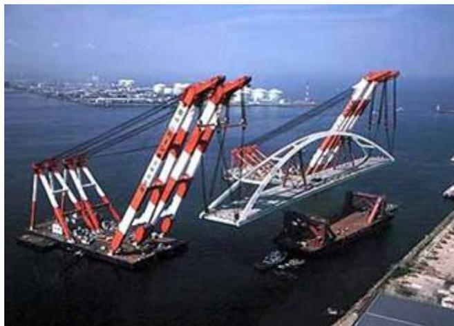
**Abbildung 36:** Transport der Shinhamadera Brücke, Japan 1991, 254 m
