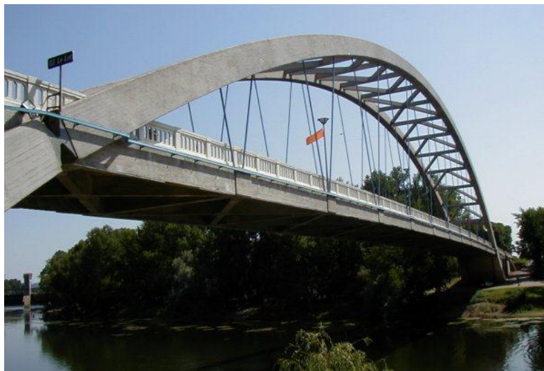
Bild 2: Nielsen-Brücke in Castelmoron, Frankreich
