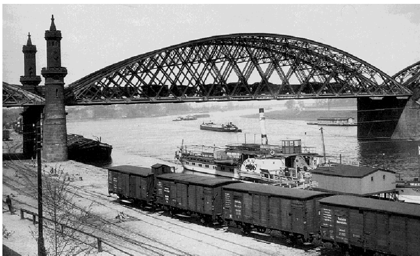
Bild 1: Elbebrücke Riesa, Deutschland
