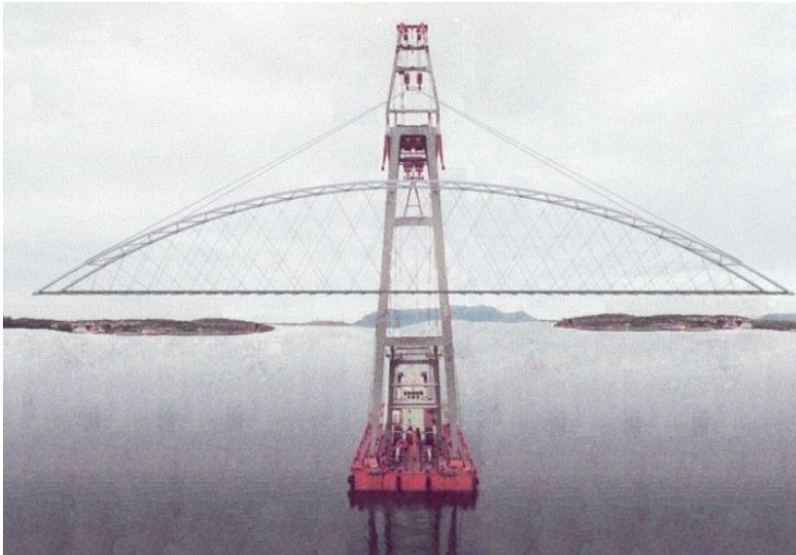
Fig. 17. «Uglen» lifting the main span in the Åkvik Sound Bridge
