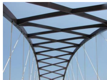
Fig. 5 – Rib Bracing
