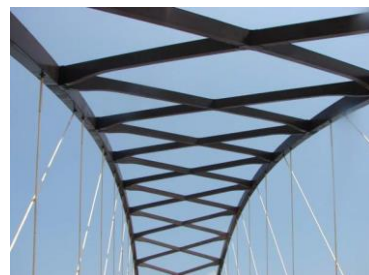
Fig. 5 – Rib Bracing
