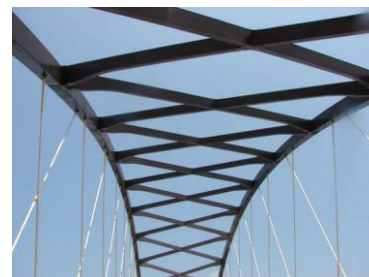
Fig. 5 – Rib Bracing
