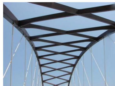
Fig. 5 – Rib Bracing
